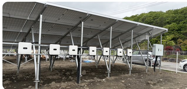
50kW 低圧 スクリュー杭打ち
