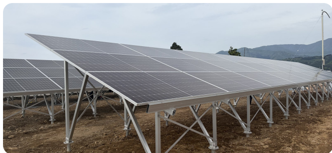
50kW 低圧 スクリュー杭打ち
