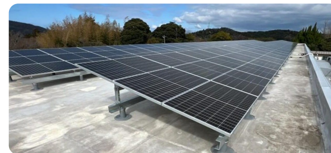
陸屋根 アンカー工法
