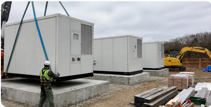
コンテナ型蓄電池 クレーン据付施工（イラスト）
